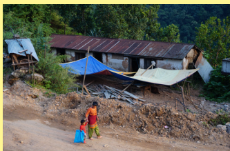
Bauplatz: Alte Grundschule
