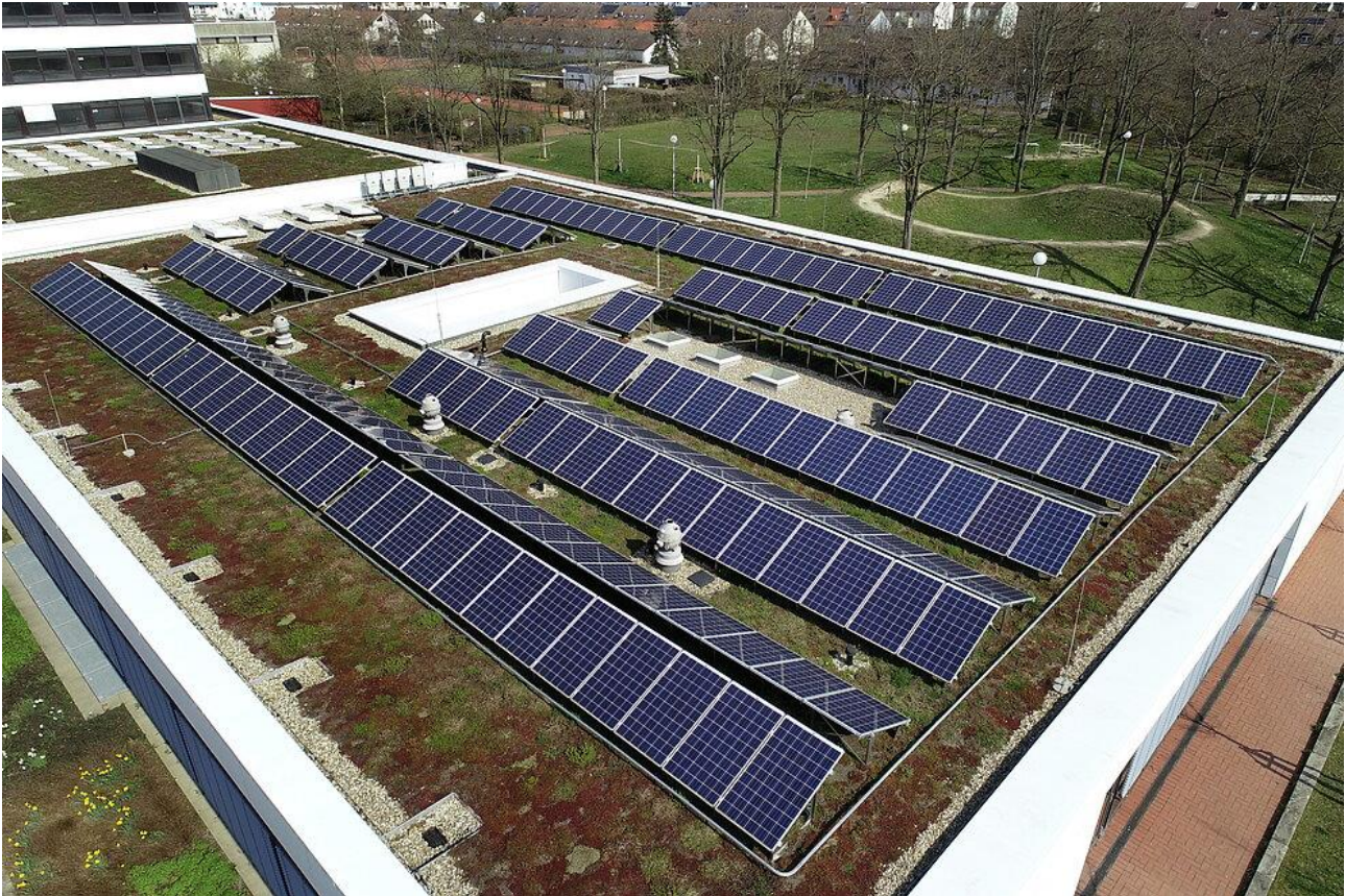
Abbildung 24: Die Photovoltaikanlage auf dem Gründach des Otto-Hahn-Gymnasiums in Karlsruhe © Stadt Karlsruhe, HGW
