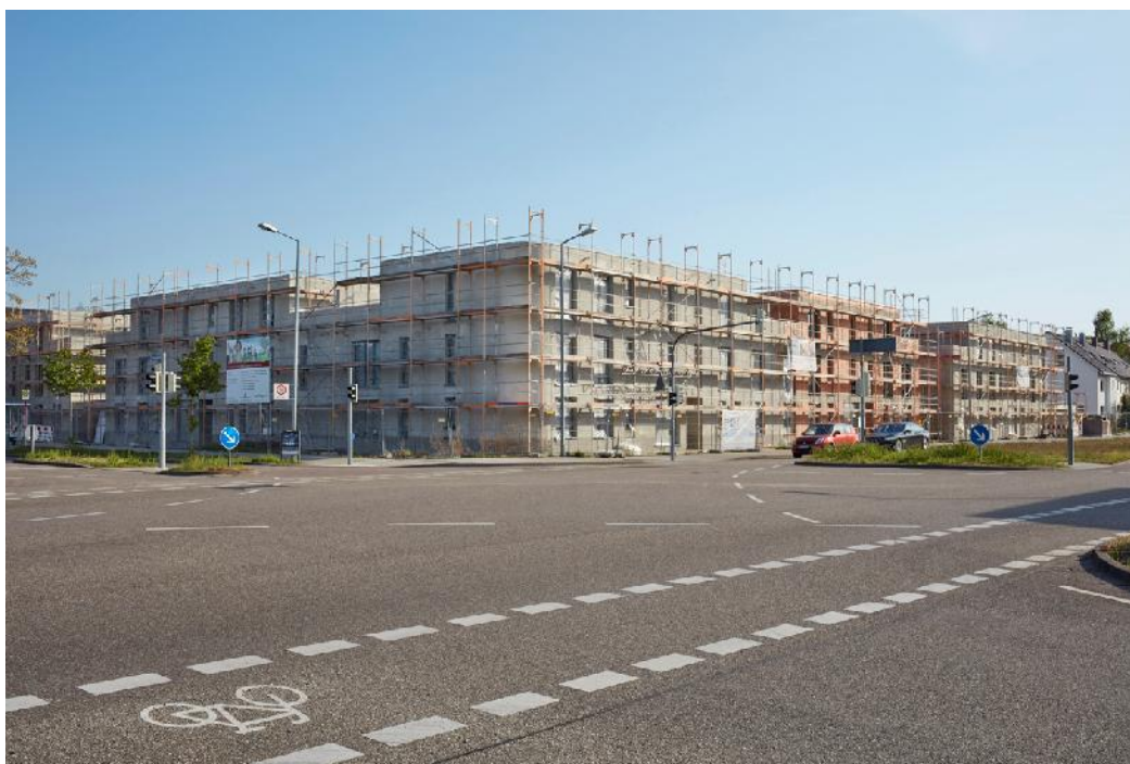
Neubau von Sozialwohnungen durch die Volkswohnung in der Sudetenstraße Ecke Annweilerstraße mit Unterstützung durch die Karlsruher Wohnraumförderung KaWoF
