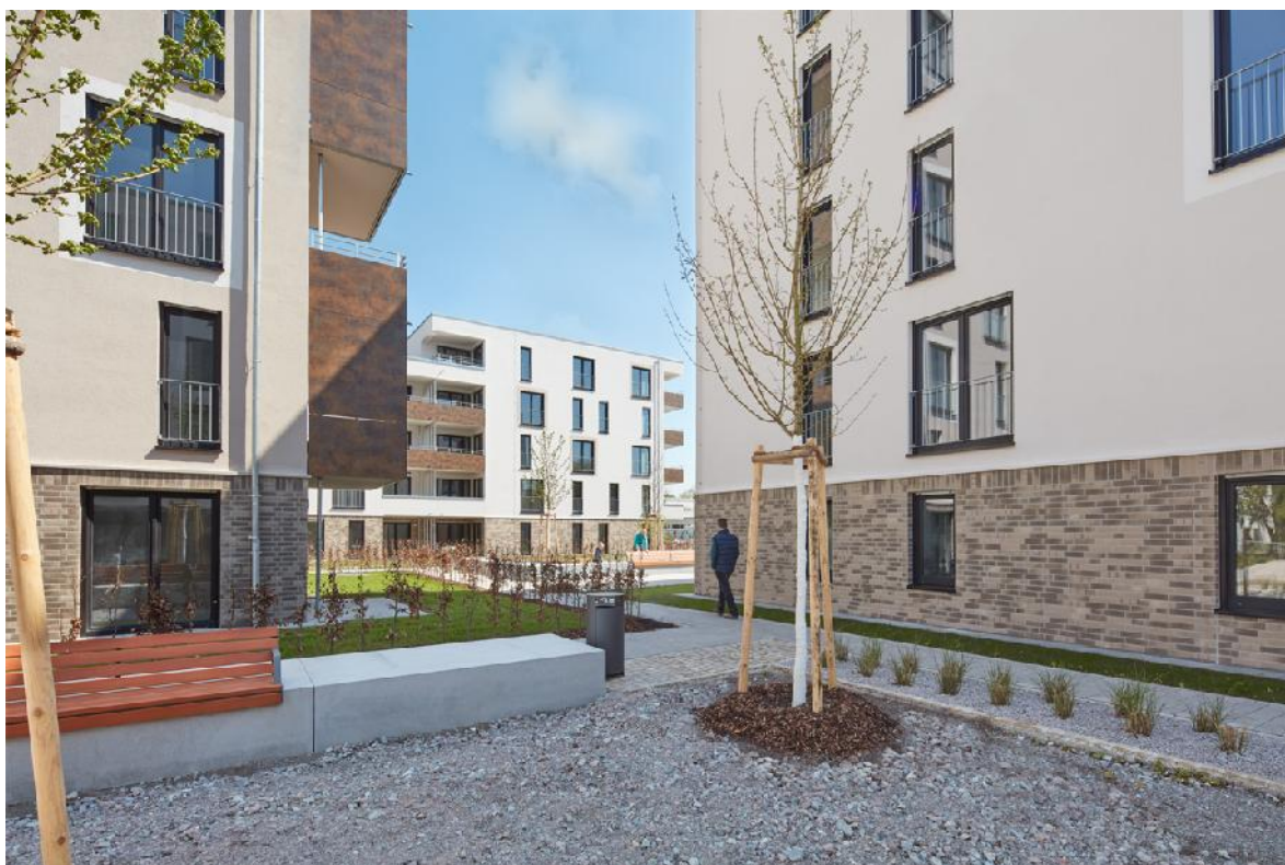
Sozialwohnungen der Volkswohnung in der Forststraße mit Unterstützung durch die Karlsruher Wohnraumförderung KaWoF sowie unter Anwendung des Karlsruher Innenentwicklungskonzepts KAI
