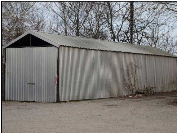
5: Ganz im Osten befindet sich ein einfach aufgestellter kleinerer Wellblechschuppen.
