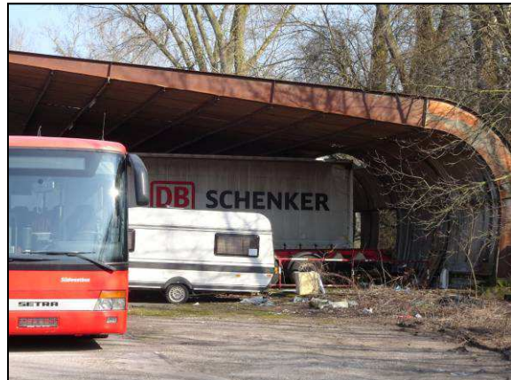
6: Blick auf den größeren Wellblechunterstand im Süden des Geländes am Dammfuß. Im Hintergrund einige größere Pappeln.
