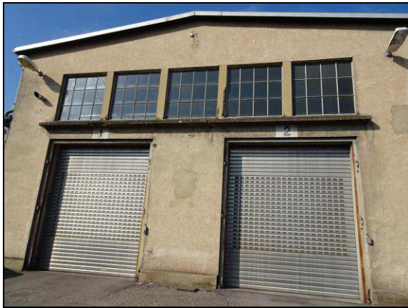
3: Eines von den beiden Nebengebäuden, die als Kfz-/ Buss-Halle genutzt wird.
