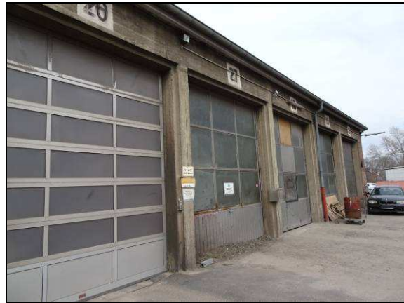
4: Blick auf die östlichen Hallen, die zurückgebaut werden sollen.
